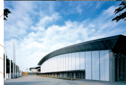
所沢市民体育館の外観
